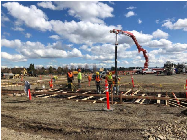
-Concrete pour in progress
